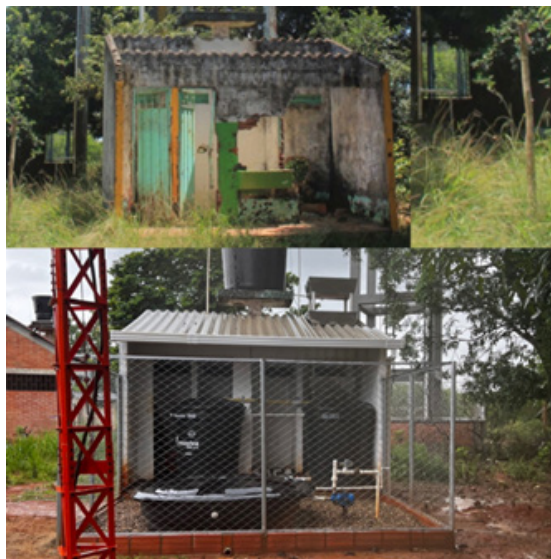
Resguardo La Victoria, Puerto López. Comparación antes y después de construida la unidad de potabilización Romero J. (2023)
