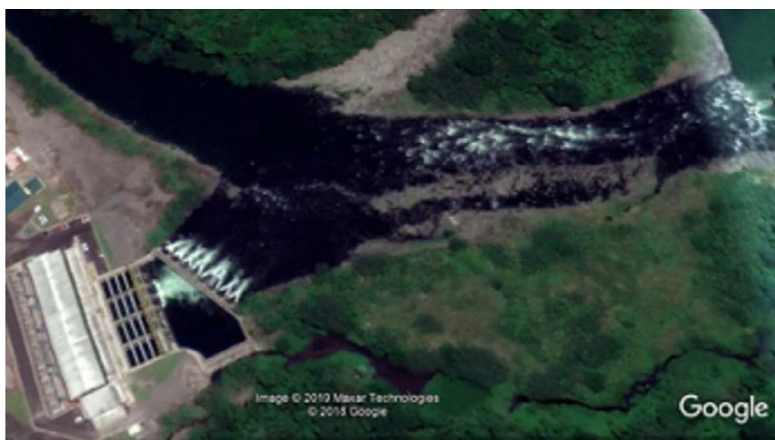
Figura 10. Vertido del caudal de compensación de una de las unidades de la casa de máquinas de la Planta Reventazón
