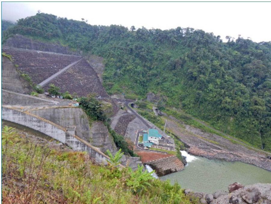
Figura 8. Minicentral de Compensación PH Reventazón. Se observa el vertido del caudal ambiental
