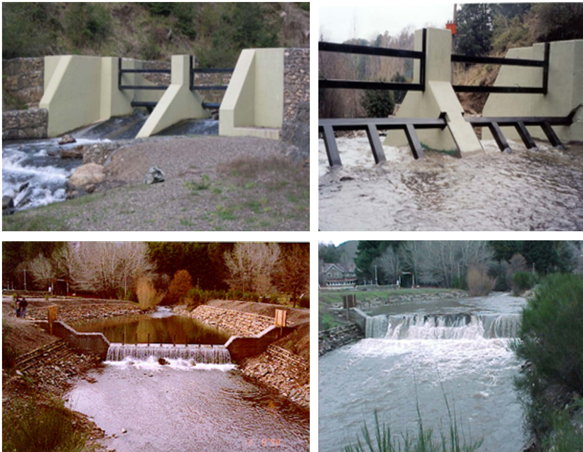
Figura 12. Obras de ingeniería diseñadas en base a una imitación de los procesos naturales
