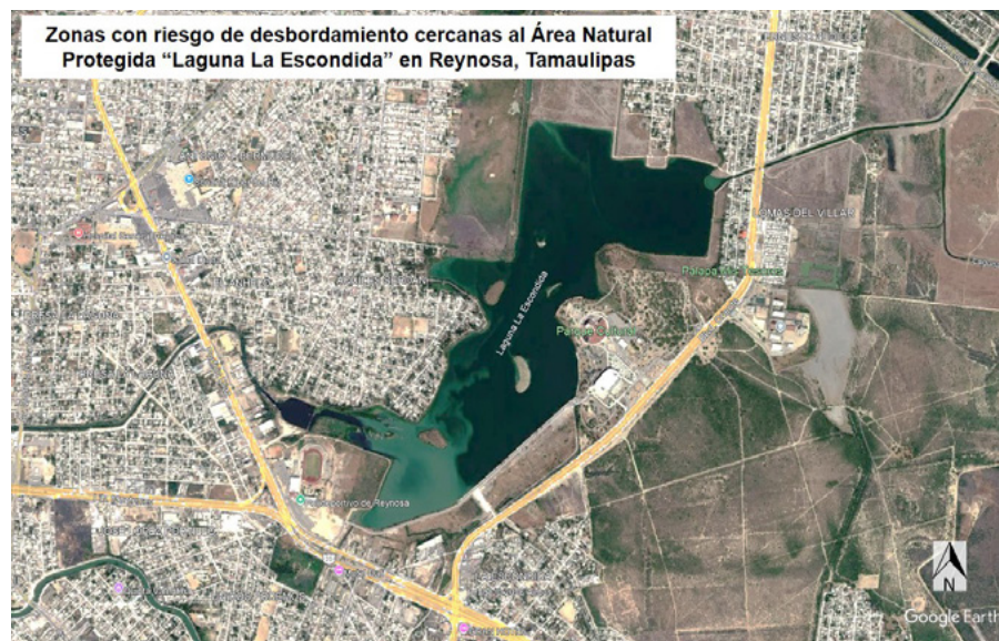
Figura 2. Zonas con riesgo de desbordamiento cercanas al Área Natural Protegida “Laguna La Escondida” en Reynosa, Tamaulipas.
