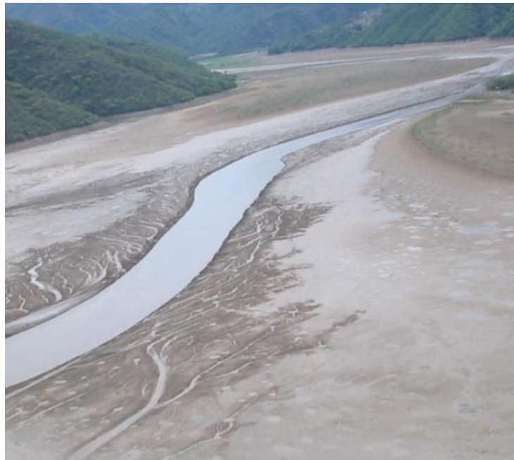
Figura 5.2 Sedimentación a la entrada del embalse de la presa El Caracol de la CFE
